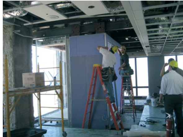
Eine von drei Kabinen bei der Montage
